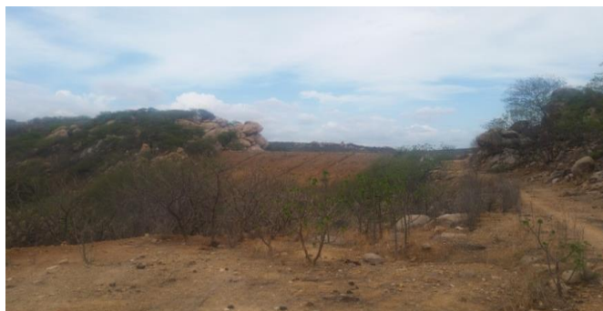
Foto 01: Vista de jusante para barragem.
