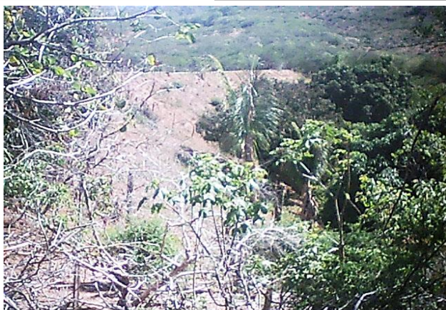
Foto 01: Vista do paramento de jusante da barragem.
