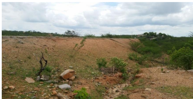
Foto 01: Detalhe do paramento de jusante da barragem.
