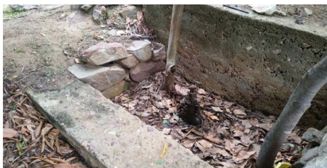
Foto 02: Tomada d'água a jusante da barragem.
