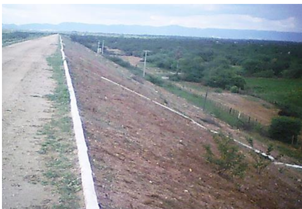
Foto 01: Paramento de jusante.
