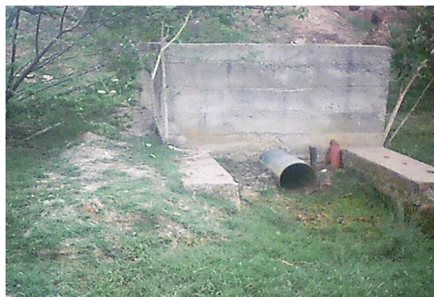
Foto 02: Tomada d'água - liberação para jusante.
