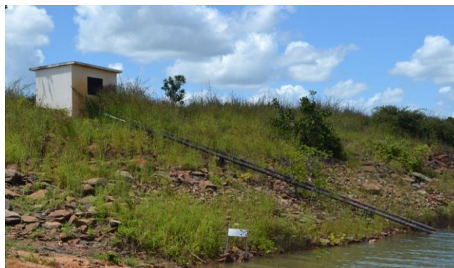
Foto 02: Casa e dutos de comando das comportas da tomada d'água.
