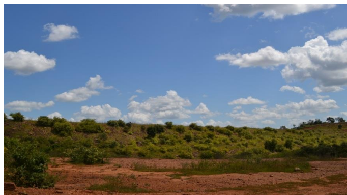
Foto 01: Vista de jusante para o barramento.
