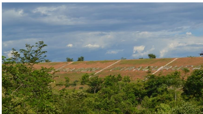
Foto 01: Vista de jusante para a barragem.
