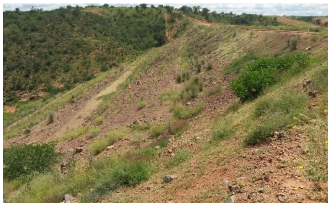
Foto 01: Paramento de jusante.
