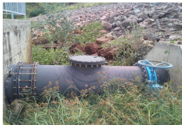
Foto 02: Tubulação da tomada d'água.
