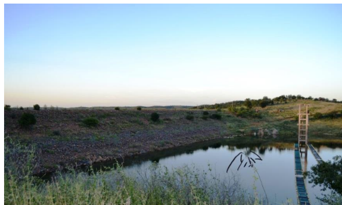
Foto 01: Vista de montante para a barragem.
