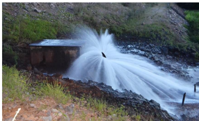
Foto 02: Válvula dispersora - liberação para jusante.
