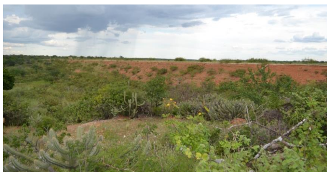
Foto 01: Vista de jusante para a barragem.
