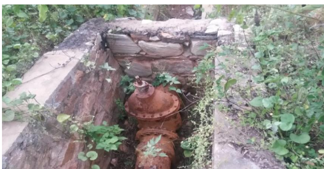
Foto 02: Registro gaveta na saída na tomada d'água.
