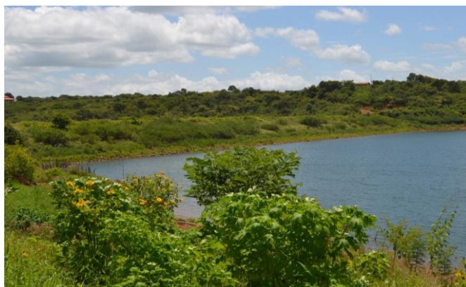
Foto 01: Vista de montante para barragem.
