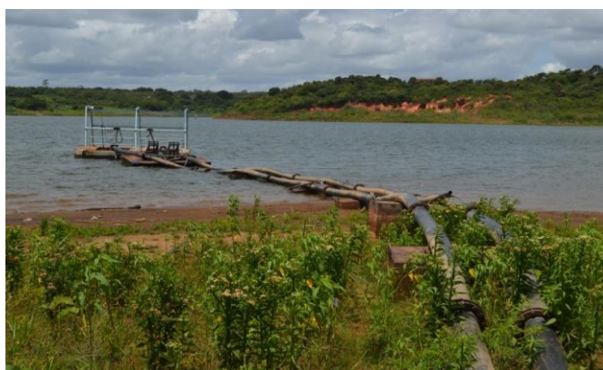
Foto 02: Captação sobre flutuantes - AGESPISA.
