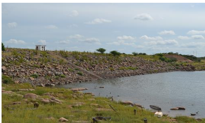
Foto 01: Detalhe do paramento de montante.
