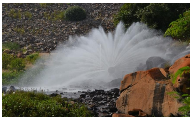
Foto 02: Liberação para jusante - válvula dispersora.
