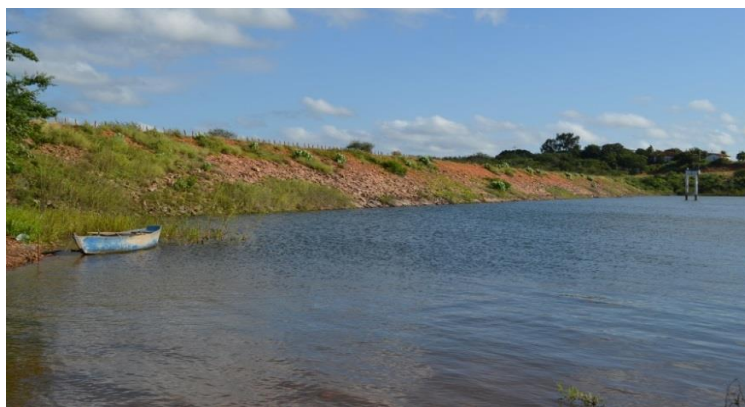
Foto 01: Vista de montante para a barragem.
