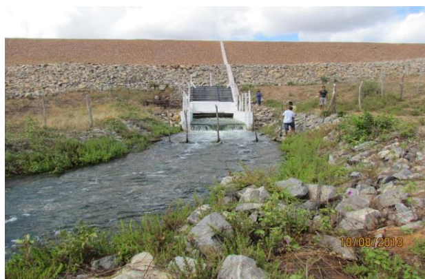
Foto 02: Vista de jusante para barragem. (Fonte: Google Earth)
