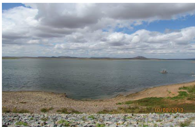
Foto 01: Vista da barragem para montante. (Fonte: Google Earth)
