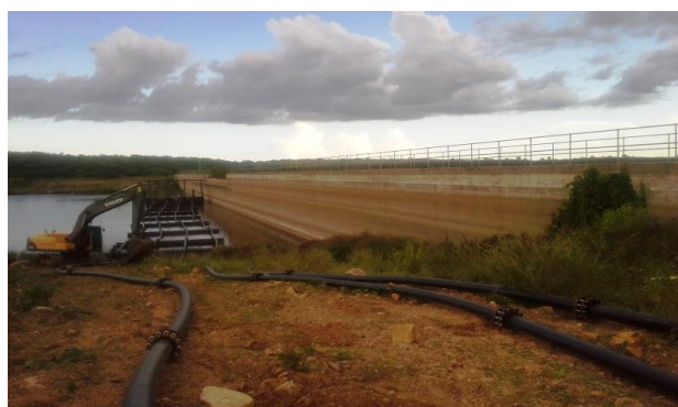
Foto 01: Detalhe do paramento de montante.
