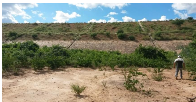
Foto 01: Vista de jusante da barragem.
