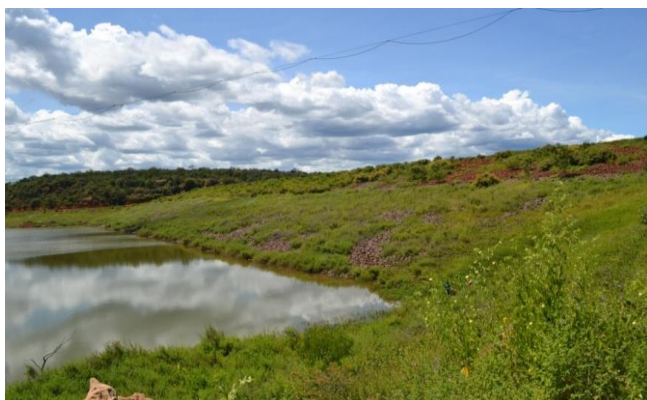
Foto 01: Vista de montante para barragem principal.
