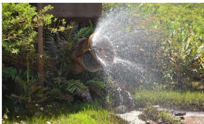
Foto 02: Válvula dispersora - liberação para jusante.
