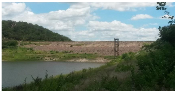
Foto 01: Vista de montante para a barragem.
