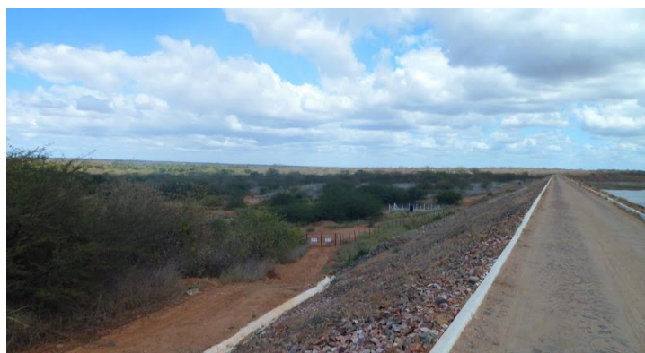
Foto 01: Vista lateral do corpo da barragem. (Fonte: Google Earth)
