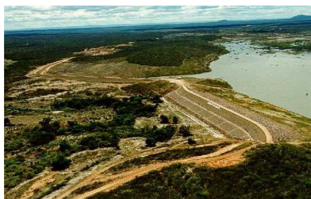
Foto 02: Vista de jusante para a barragem. (Fonte: http://atlas.srh.ce.gov.br/ )
