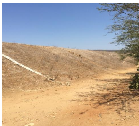
Foto 01: Detalhe do paramento de jusante.
