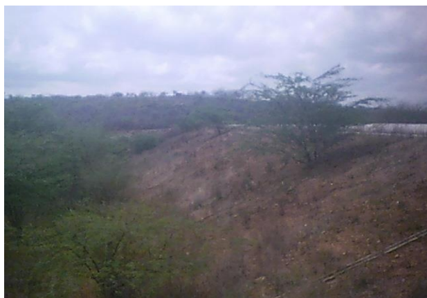
Foto 01: Vista de jusante para a barragem.
