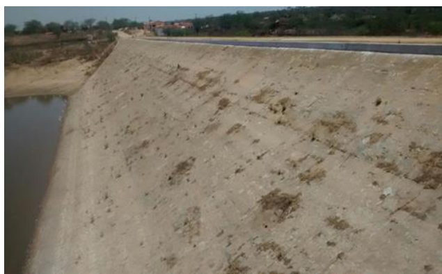
Foto 01: Detalhe do paramento de montante.
