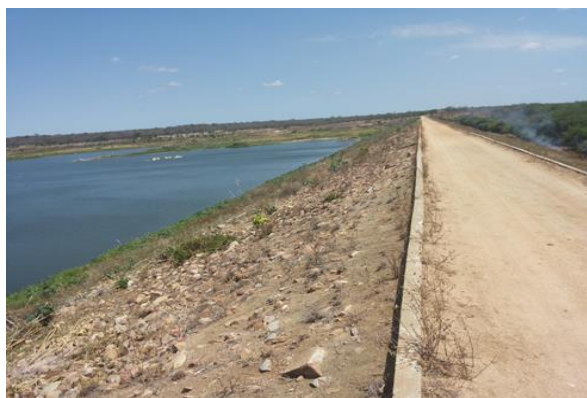
Foto 01: Vista do paramento de montante.
