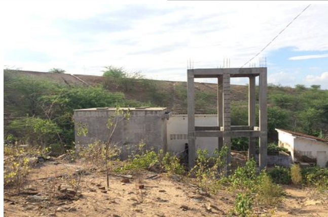
Foto 01: Vista de jusante para barragem principal.
