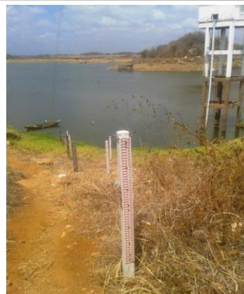
Foto 02: Conjunto de régua no reservatório
