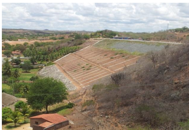
Foto 01: Vista de jusante para barragem principal.
