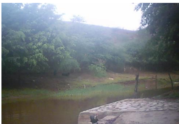
Foto 01: Vista de jusante para a barragem.
