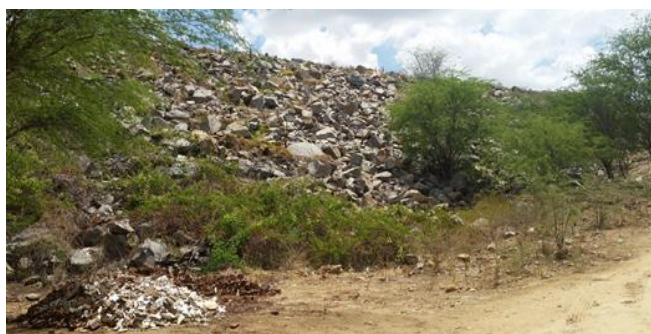
Foto 01: Paramento de jusante.
