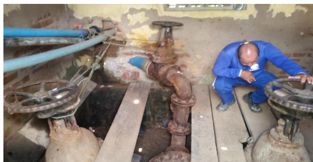
Foto 02: Derivações tomada d'água da barragem.
