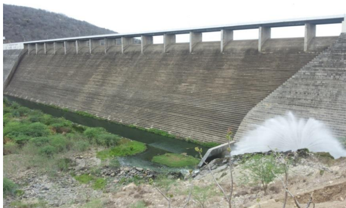
Foto 01: Vista de jusante para a barragem.
