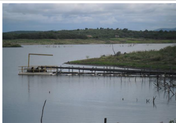
Foto 02: Captação por bombas sobre flutuantes. (Fonte: Google Earth)
