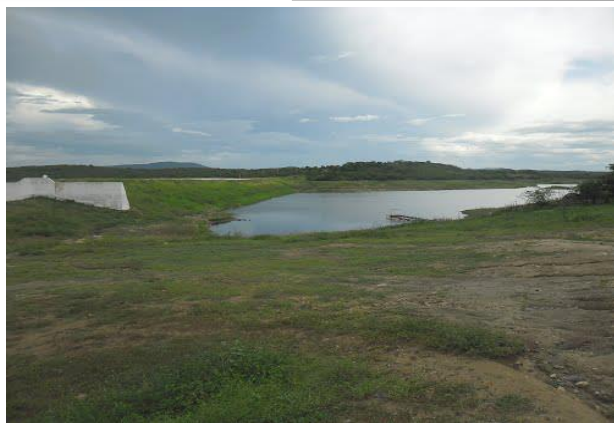
Foto 01: Vista de montante para a barragem. (Fonte: Google Earth)
