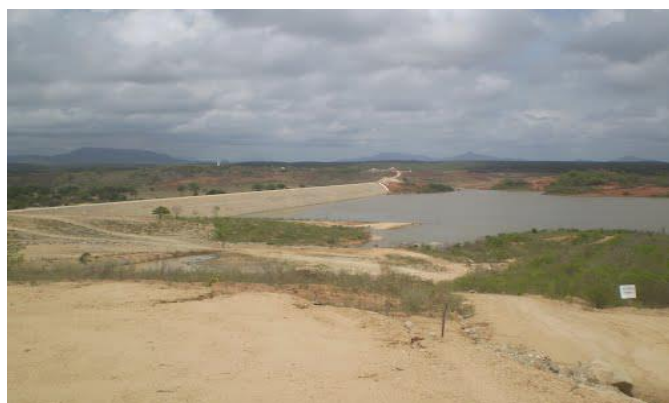
Foto 01: Vista de montante para a barragem. (Fonte: Google Earth)
