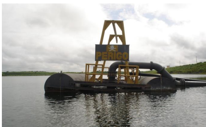
Foto 02: Captação sobre flutuantes - SAAE. (Fonte: Google Earth)
