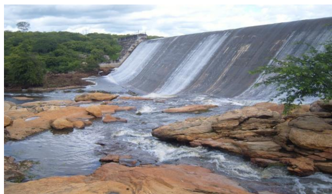
Foto 02: Vista da margem esquerda para barragem. (Fonte: Google Earth)
