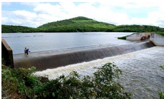
Foto 02: Vista do vertedouro. (Fonte: http://www.amtrapia1510.com.br/ )
