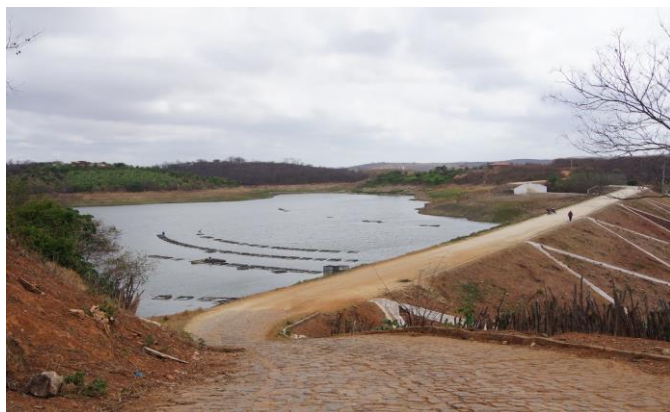
Foto 01: Vista lateral do corpo da barragem. (Fonte: Google Earth)
