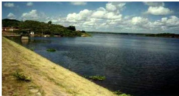
Foto 02: Vista da barragem para montante. (Fonte: http://atlas.srh.ce.gov.br/ )
