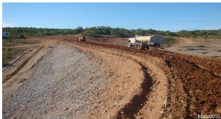
Foto 01: Coroamento da barragem (em construção) Fonte: http://atlas.srh.ce.gov.br/
