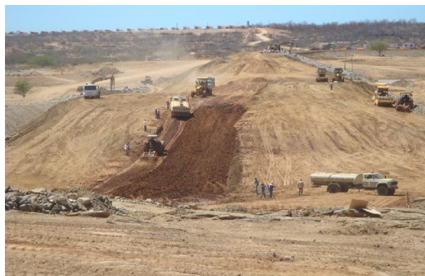
Foto 02: Vista geral do maciço terroso (em construção) Fonte: http://atlas.srh.ce.gov.br/
