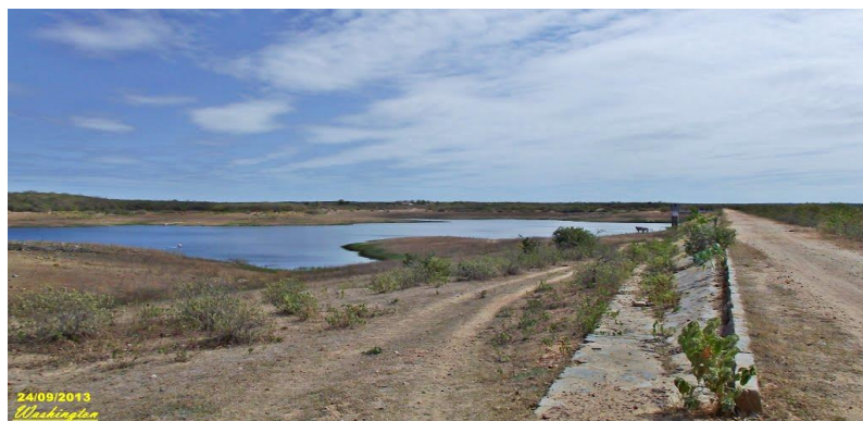
Foto 01: Vista lateral do corpo da barragem. (Fonte: Google Earth)
