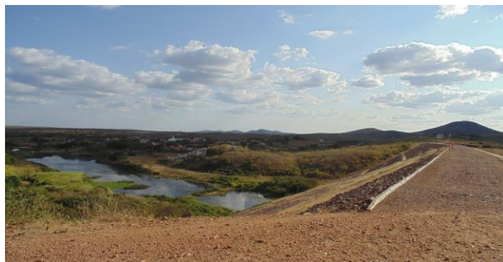
Foto 01: Vista lateral do corpo da barragem. (Fonte: Google Earth)
