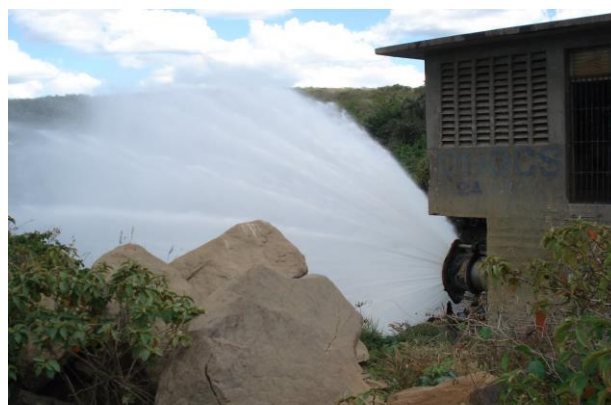
Foto 02: Detalhe da válvula dispersora. (Fonte: Google Earth)
