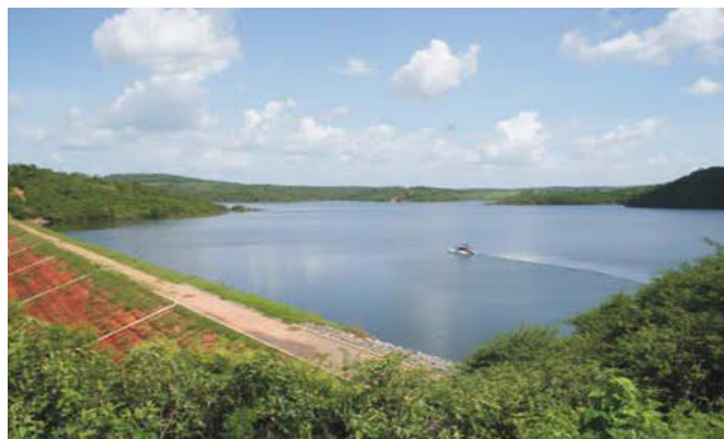
Foto 02: Vista de jusante para barragem. (Fonte: Google Earth)
