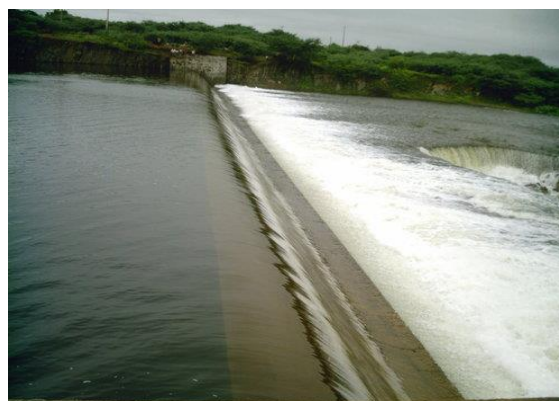
Foto 02: Vertedouro da barragem. (Fonte: Google Earth)
