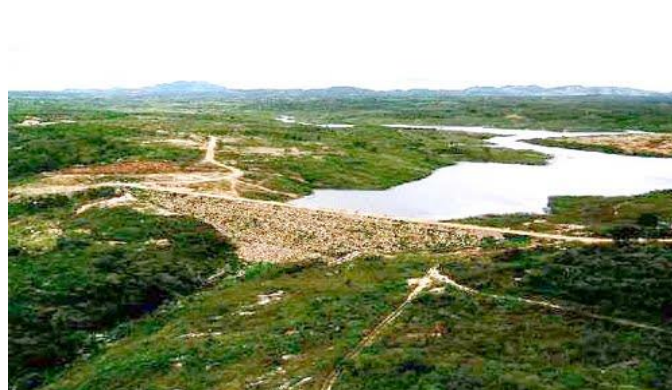
Foto 02: Vista de jusante para barragem. (Fonte: Google Earth)
