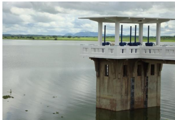
Foto 02: Torre de comando da tomada d'água. (Fonte: Google Earth)
