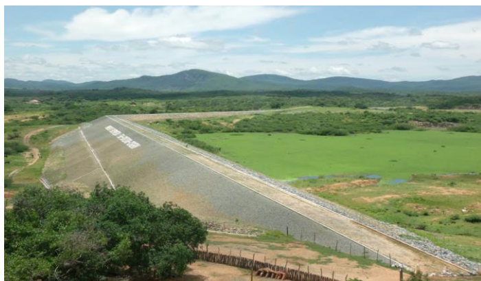
Foto 01: Vista de jusante para a barragem. (Fonte: Google Earth)
