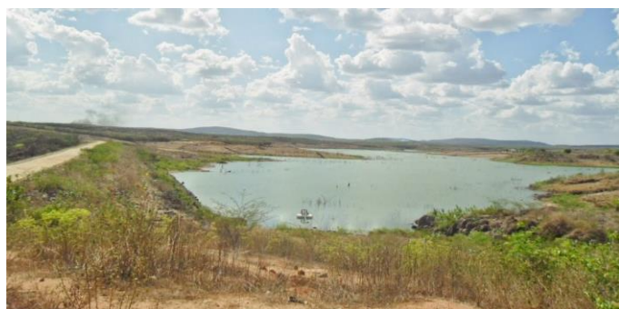
Foto 01: Vista lateral do corpo da barragem. (Fonte: http://blogdeirapuanpinheiro.blogspot.com.br/ )
