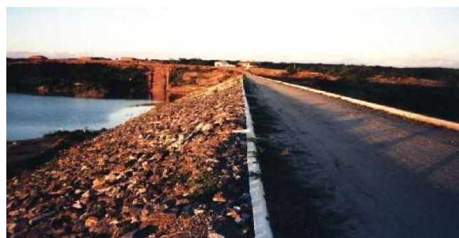
Foto 02: Detalhe do paramento de montante. (Fonte: http://atlas.srh.ce.gov.br/ )
