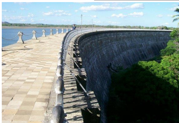
Foto 01: Vista lateral do corpo da barragem. (Fonte: Google Earth)
