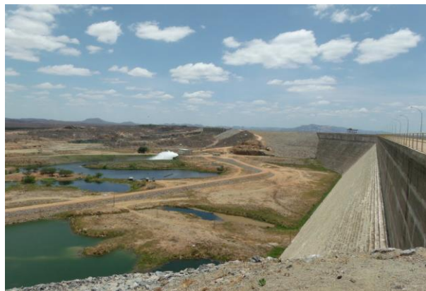
Foto 01: Vista lateral do corpo da barragem. (Fonte: Google Earth)
