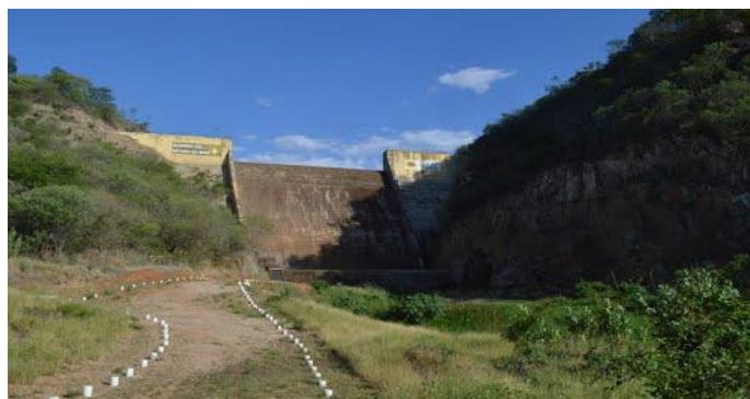
Foto 01: Vista de jusante para barragem. (Fonte: Google Earth)
