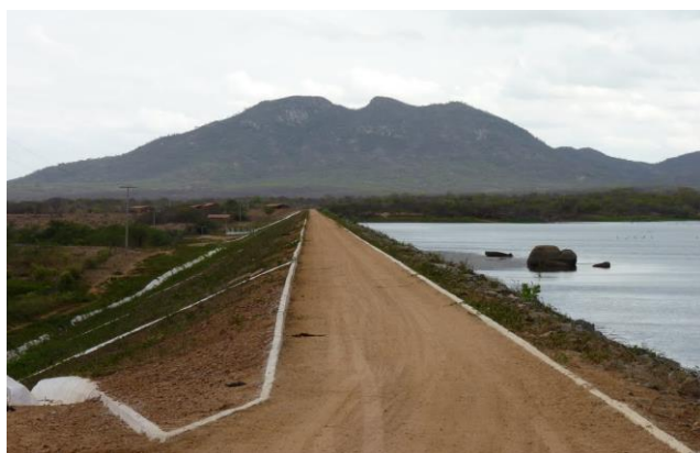
Foto 01: Vista lateral do corpo da barragem. (Fonte: Google Earth)
