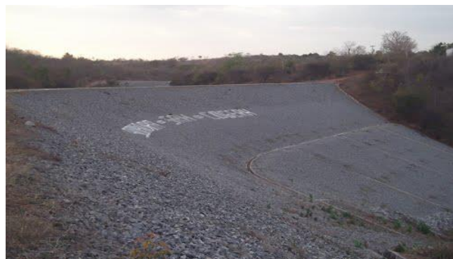
Foto 02: Detalhe do paramento de jusante. (Fonte: Google Earth)
