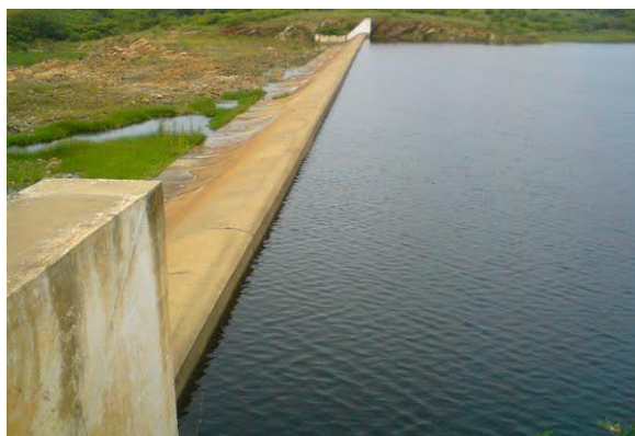
Foto 01: Vertedouro da barragem. (Fonte: Google Earth)
